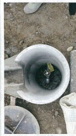
排水工の補修工事(松本・北神地)
