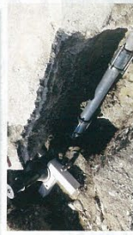
細かん施設の破損部分の補修工事 (松本・栗坂6工区)
