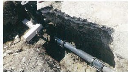
畑かん施設の破損部分の補修工事 (松本・県ほ6工区)
