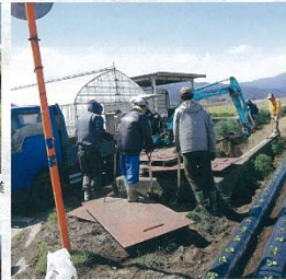
施設の点検と泥上げ作業(岩垂原排水路)
