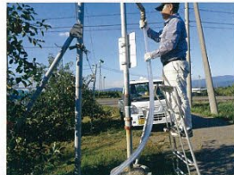
畑かん施設の点検&機能診断(県ぼ9工区)
