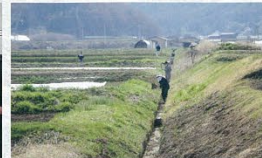
農業用水路の点検&機能診断並びに泥上げ作業(原田耕作)
