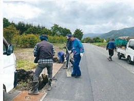
水路の点検&機能診断(中下原平林)
