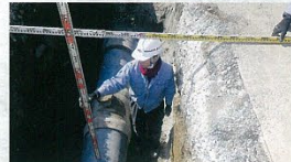
本管の補修工事(塩尻・岩垂原)
