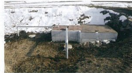
集水樹の補修工事 (松本・開パイ1工区)
