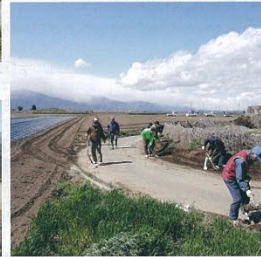
農道路肩の維持等作業(岩垂原)
