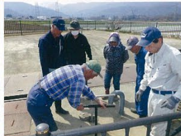
畑かん施設の点検&機能診断(開バイ2工区)
