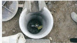
排泥工の補修工事(松本・北耕地)
