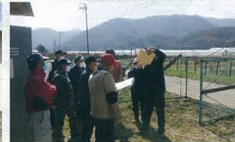
畑かん施設の点検等作業(桔梗ヶ原2工区)
