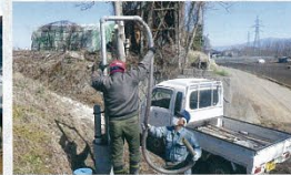
雑用水施設の管、バルブ及びホース点検等作業(桔梗ヶ原4工区)
