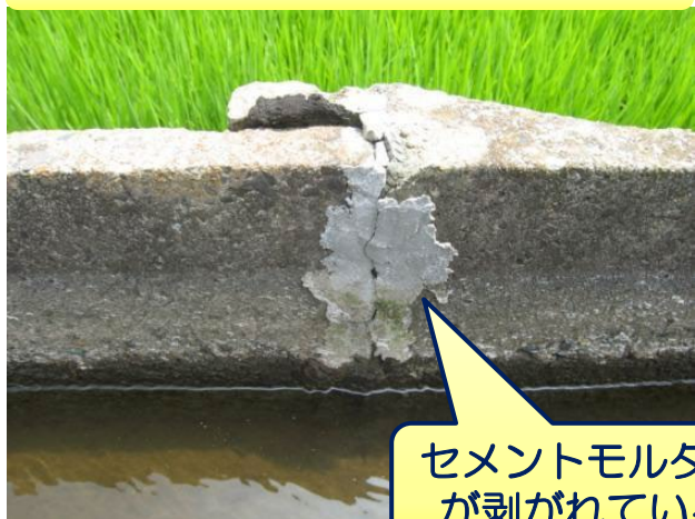
セメントモルタルによる補修
