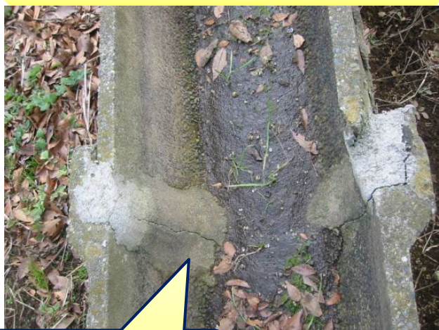
セメントモルタルによる補修
