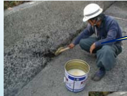
プライマー塗布
