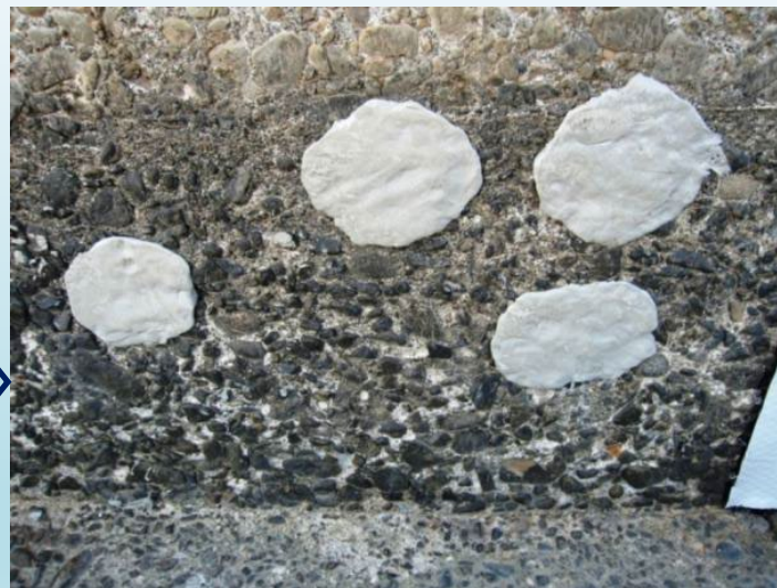
水中パテ施工後
