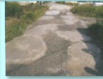
農道の窪みの補修
