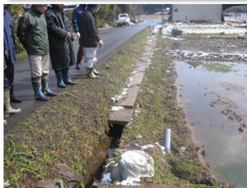
着工前に、現地で施工業者と工事内容を確認します。
