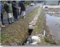
施設の機能診断
