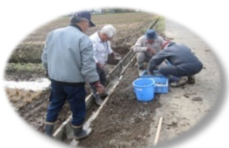
自主施工での水路補修
