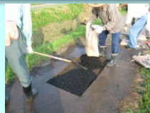
農道舗装の打換え
