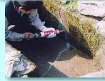
水路のひび割れ補修
