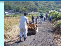
未舗装農道を舗装
